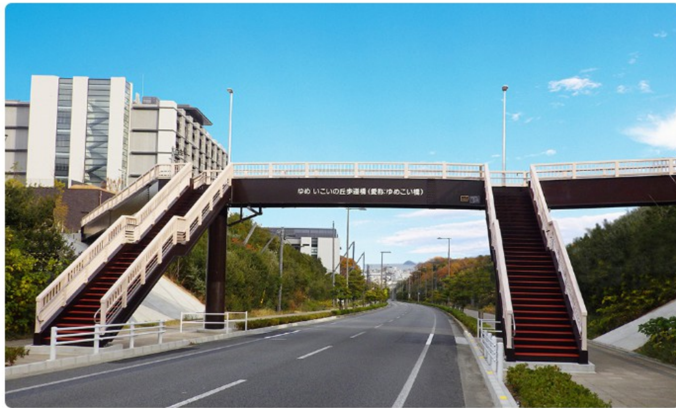
加計学園歩道橋
