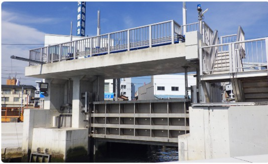
今治内港水門
